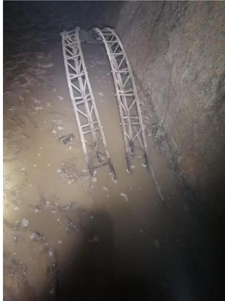
Figura N° 2.7 Marcos de Acero a ser Utilizados
