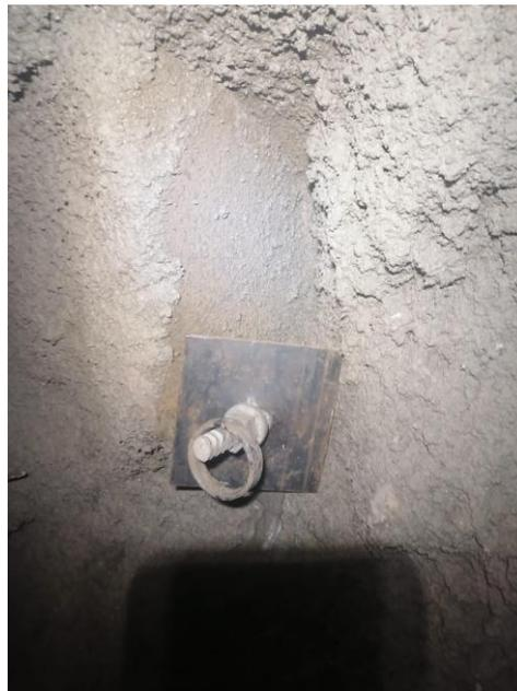
Figura N° 2.6 Pernos de Anclaje
